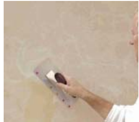
Nach der Trocknung der ersten Spachtelschicht ArteTwin Effect Gold oder Silber im Fleckverfahren oder ganzflächig aufspachteln.
