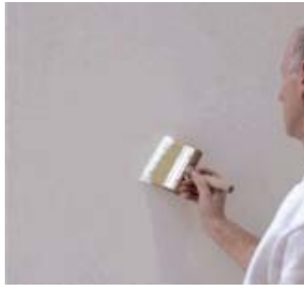
Zwischenbeschichtung aufrollen und nachwischen.
