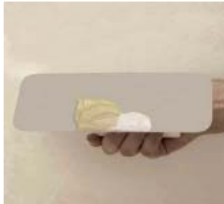
Werkstoffe nebeneinander auf der ArteTwin Spezialkelle anordnen.
