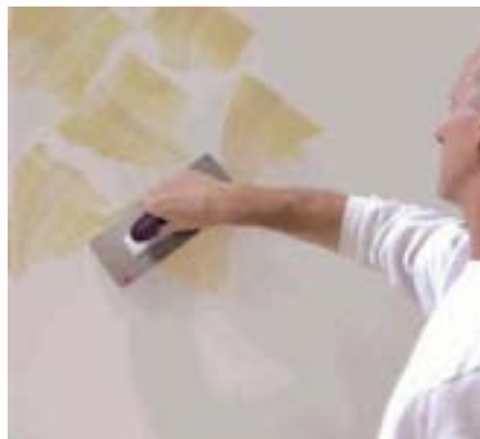
Werkstoffe im Fleckverfahren, in geringem Abstand und mit Richtungswechseln, aufspachteln.
