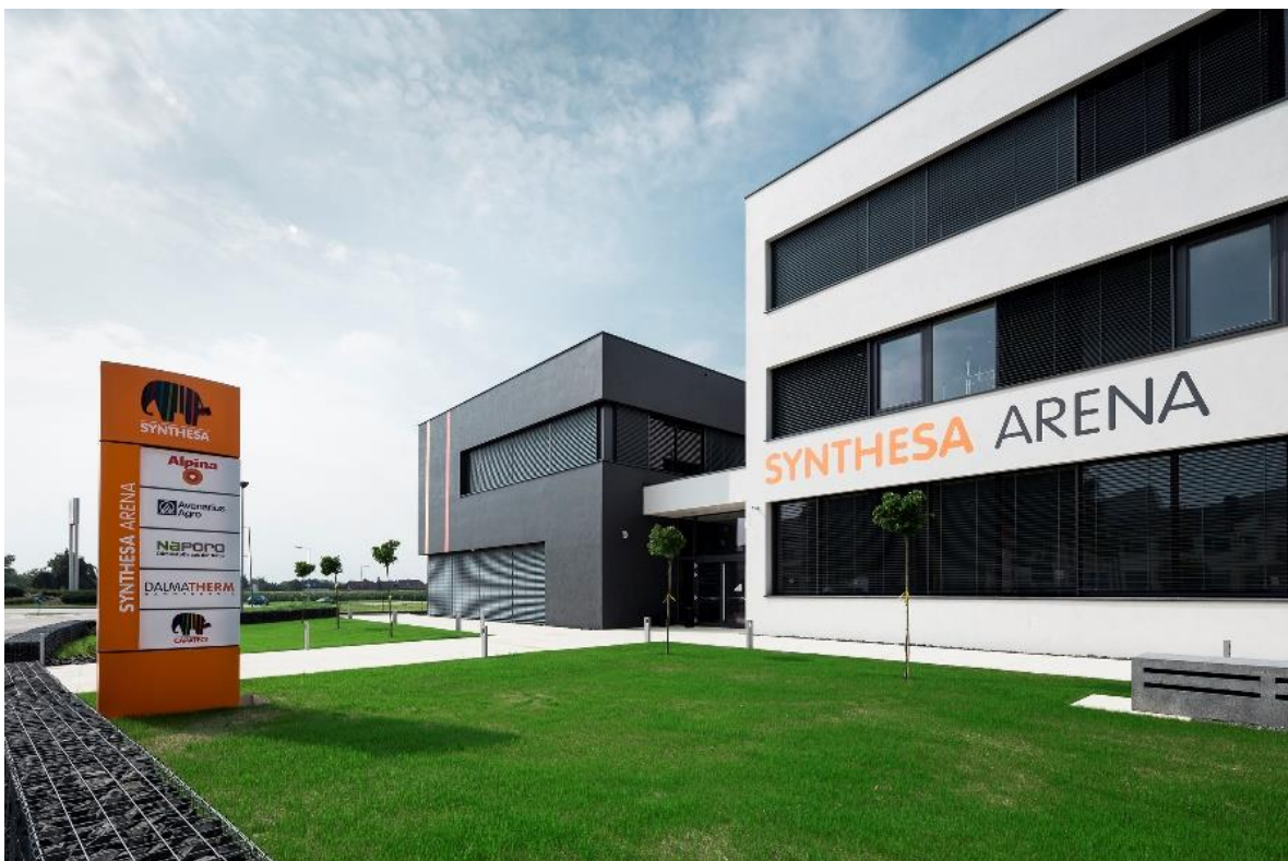
Die Ostansicht des zweiteiligen Schulungsgebäudes
