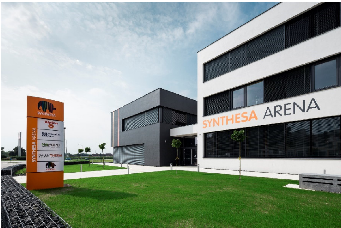
Die Ostansicht des zweiteiligen Schulungsgebäudes
